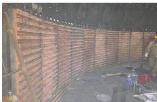
铜钢复合冷却壁安装现场图
